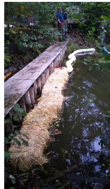
**A-Saugschläuche** können in genügender Anzahl aneinandergeschnitten **an beiden Enden mit Blindkupplungen geschlossen** zu Wasser gebracht werden. Dadurch werden sie schwimmfähig.
